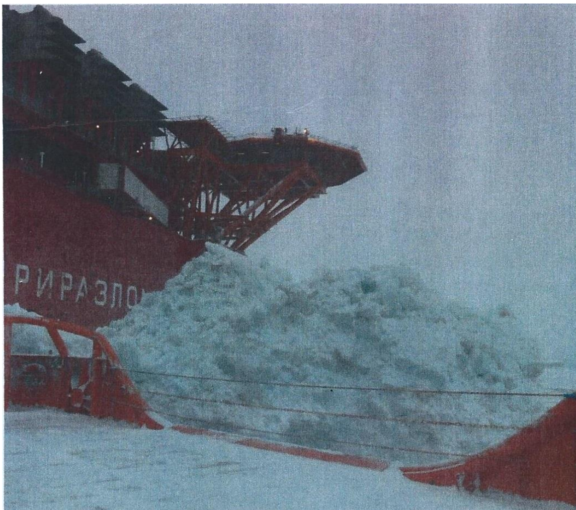
Рисунок 1. Влияние ледового нагромождения на конструкцию платформы
